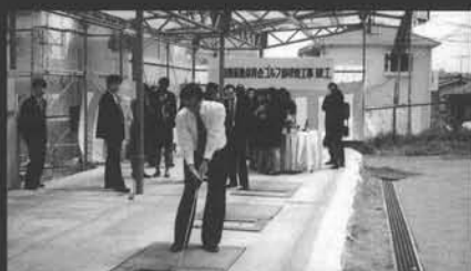
1991(平成3年)・6 日吉練習場改修。
